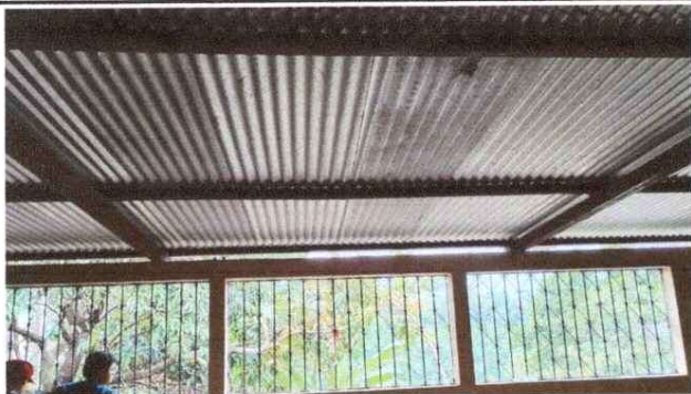
Foto1: Sustitución de lámina troquelada aluzinc calibre 26 y sustitución de soporte de metal por metal, (aula 1)
