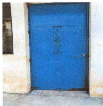
Foto 4: Sustitución de puerta de la cocina
