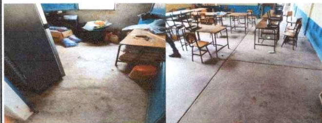
Foto 8: Sustitución de piso cerámico (cocina y aula No. 1)
