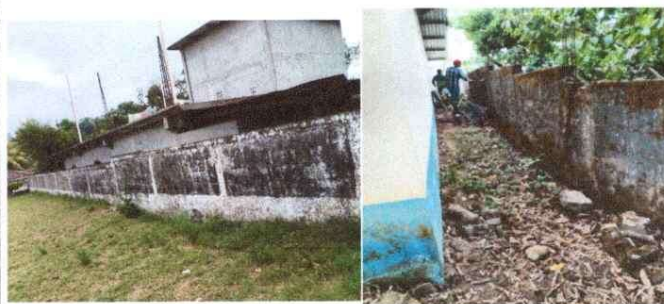
Foto 10: Repello y Pintura en muros interiores y exteriores (foto No. 1)
