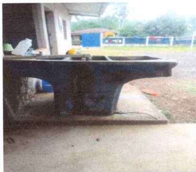
Foto13: Instalación de pila
