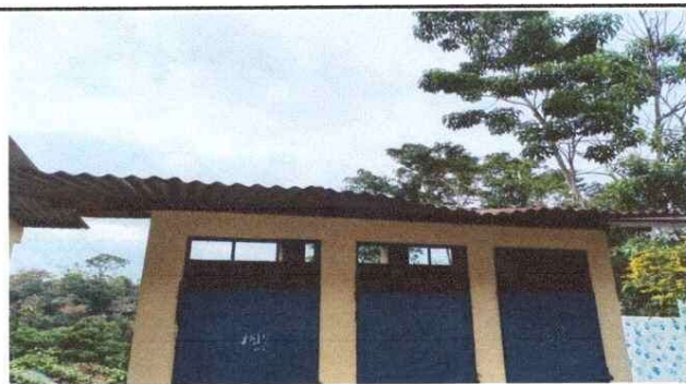
Foto 3: Sustitución de lámina troquelada aluzinc calibre 26 y sustitución de soporte de metal por metal (baños)
