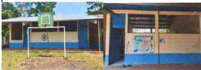
Foto 6: Mantenimiento a balcones de metal (fotos 1 y 2, parte frontal)
