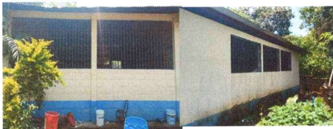
Foto7: Mantenimiento a balcones de metal (foto 3 y 4) (parte de atrás de las aulas)
