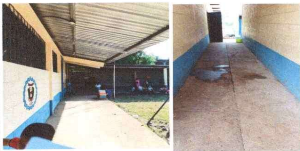
Foto 9: Sustitución de piso de duela (corredor y pasillo)
