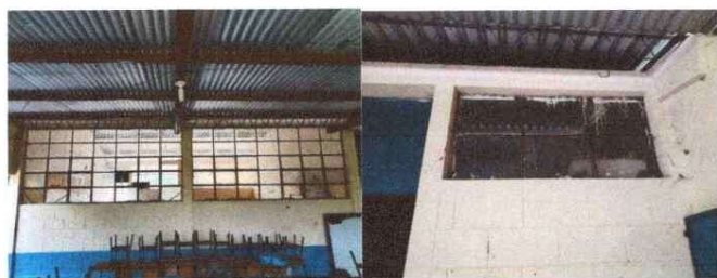
Foto 5: Sustitución de balcones de metal, (aula No. 1)
