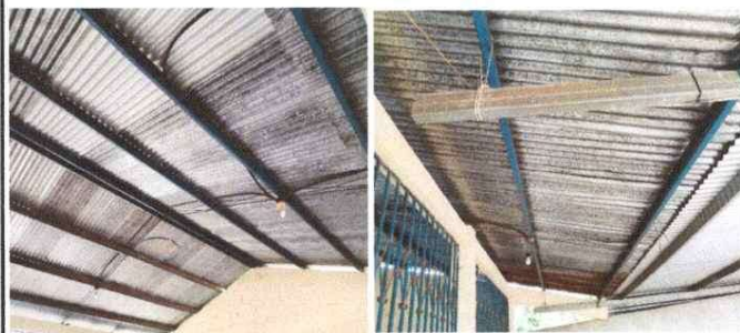
Foto 2: Sustitución de lámina troquelada aluzinc calibre 26 y sustitución de soporte de metal por metal, (parte interna y parte del corredor) (aula 2)
