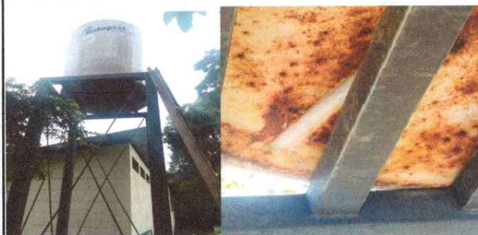
Foto 12: Sustitución de depósito de agua 1100 lt
